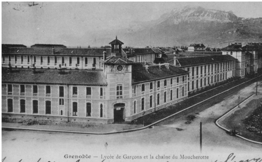
Le lycée Champollion en fin de construction
