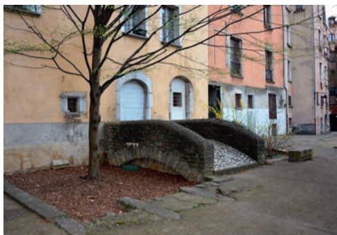
Pont Saint-Jaime au bout de la rue du même nom, qui enjambait le Verderet autrefois
