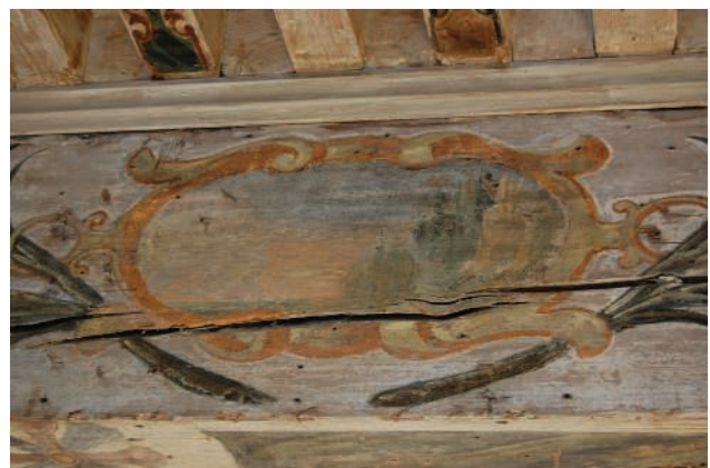
Plafond peint 10 rue Chenoise Grenoble
