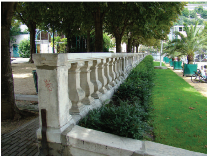
Garde-corps du Jardin de Ville à Grenoble
