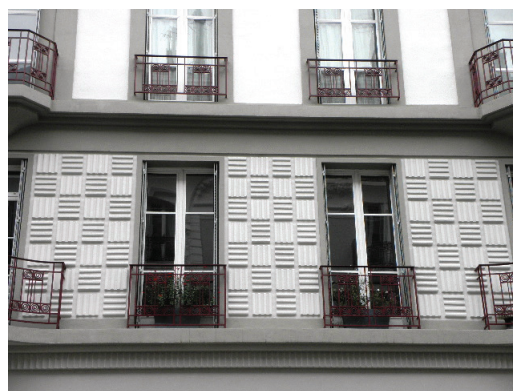
32 cours Berriat, 1928 Morard et Bonnat arch. Modénature et ornementation travaillées
