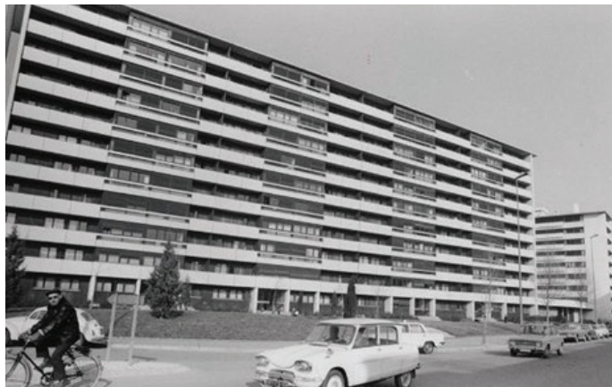
Village Olympique : 11 niveaux, un seul immeuble, implantation en recul de la rue et des voitures, espace paysager en pied
