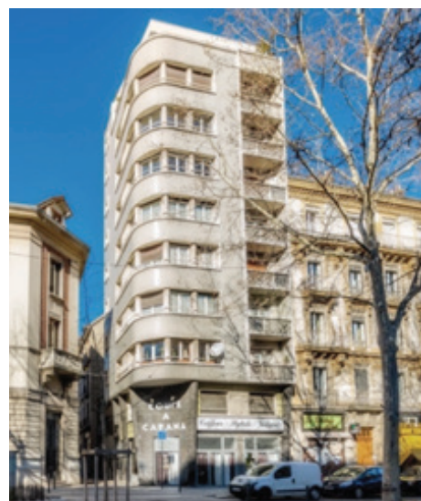
58 cours Jean Jaurès, 1955 Bardel arch.
