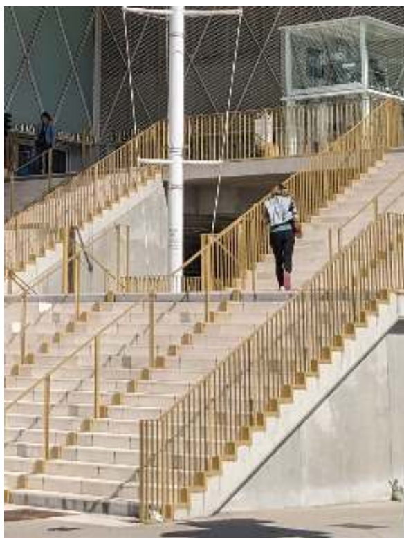
Escalier des érables avec marches en pierre beige et garde-corps dorés
