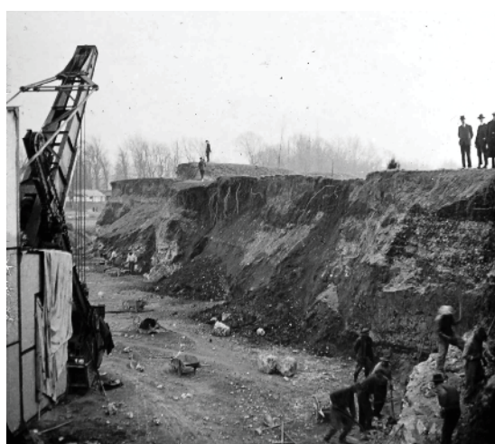
Fortifications en cours de démolition
