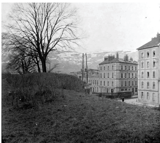
Fortifications avant démolition
