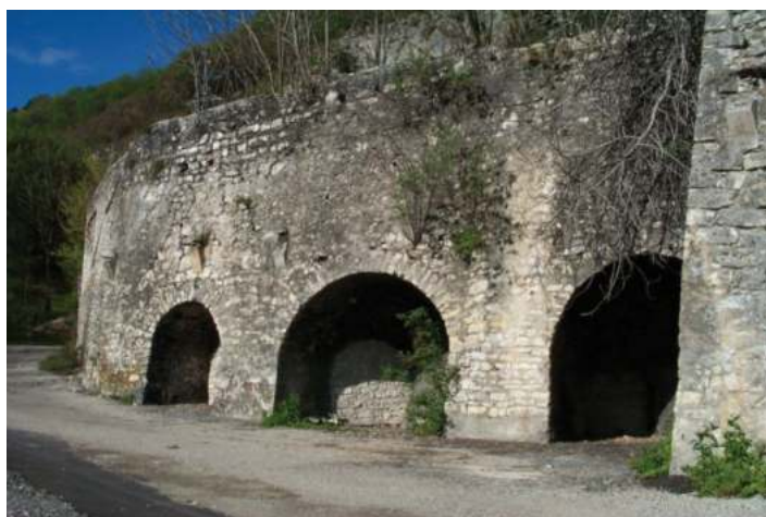
Fours à chaud de la Carrière
